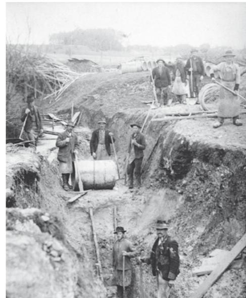
Technisches Gerät gibt es damals so gut wie keins. Verlegt werden die Rohre mit viel Manneskraft im sogenannten „Stufengraben“.
